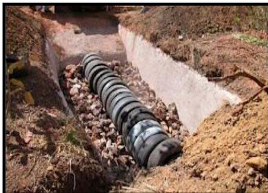
**Figura 3.** Tanque de evapotranspiração com uso de pneus (Fonte: PEREIRA, 2012).
